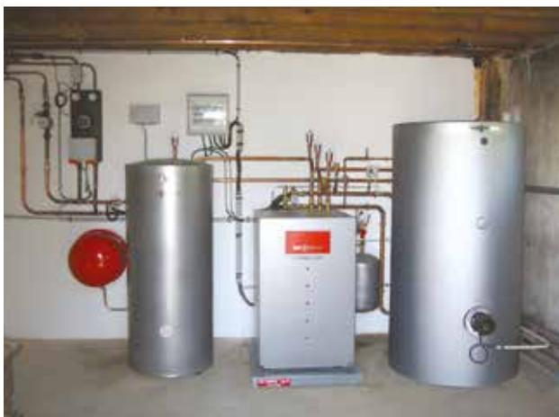
Pompe à chaleur géothermique reliée à un ballon tampon pour le chauffage et à un ballon d'eau chaude sanitaire.
