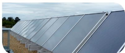
Le laboratoire départemental d'analyses de la Mayenne (LDA 53), rue du Bas des Bois à Laval, s'est équipé en 2015 d'une installation solaire thermique de 19 m². L'installation permet de couvrir 20% des besoins soit 6 400 kWh, pour un coût de 19 880€ HT.
